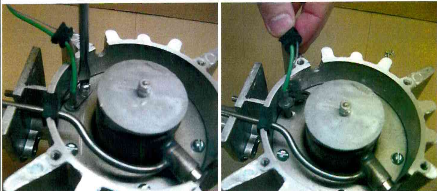
Рисунок 24 Демонтаж индикатора пламени
