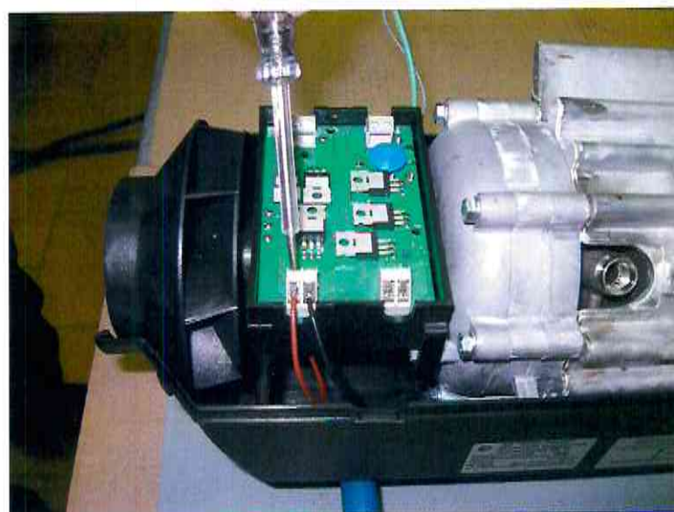
Рисунок 19 Демонтаж проводов электродвигателя нагнетателя воздуха
